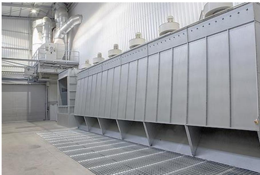
*Рис. 3.12.* Устройство обеспыливания завальной ямы фирмы PETCUS
